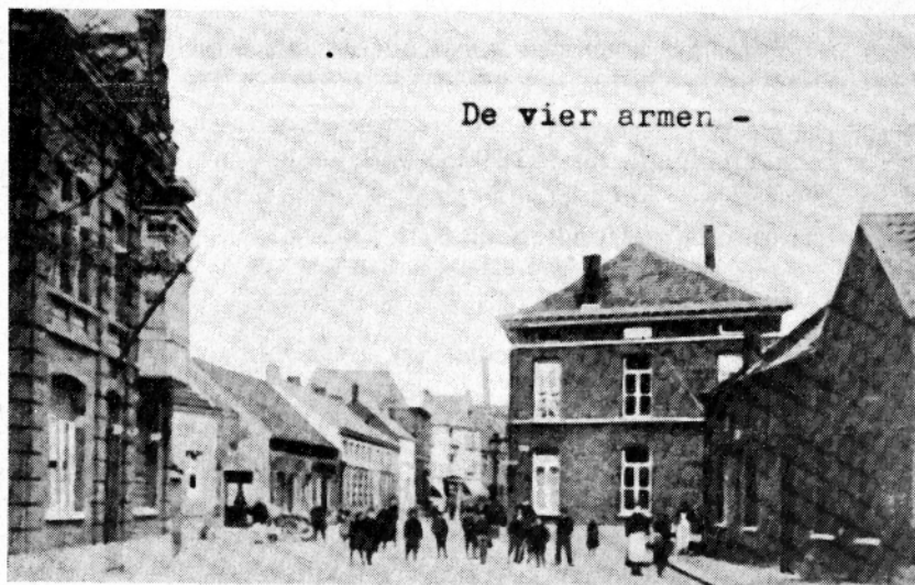
De straat op de achtergrond is de Nieuwstraat. Rechts op het voorplan een oud gebouw, dat afgebroken werd begin augustus 1914. Zo werd de mogelijkheid geschapen voor de aanleg van het «Pleintje».
