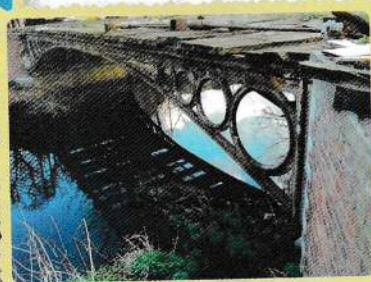
De gietijzeren boogbrug is waarschijnlijk de eerste gietijzeren brug op het vaste land en werd rond 1797, samen met het kasteel gebouwd.
