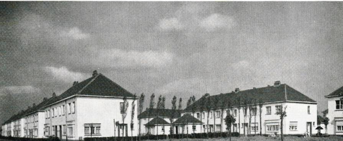
48 woningen van de Maatschappij, in opbouw aan de Vakbondstr.
